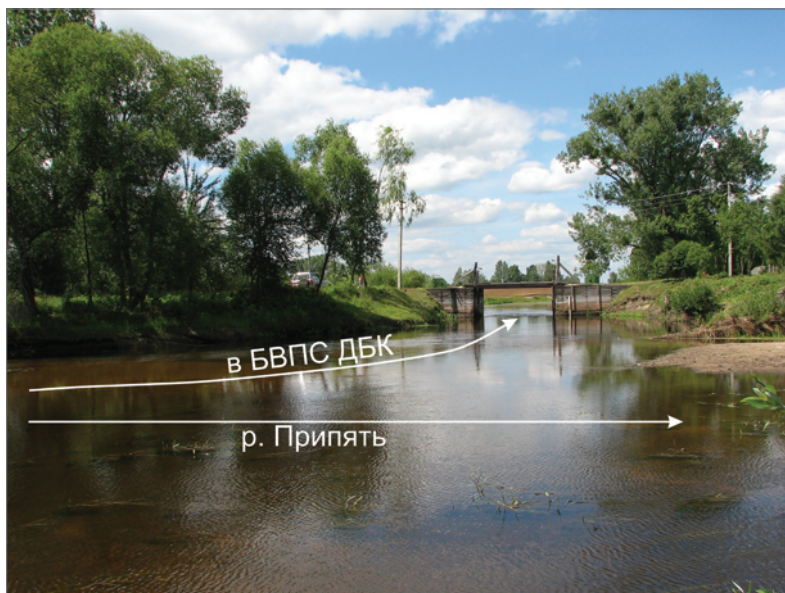
Рисунок 2.13 — Верхнеприпятский гидроузел (Выжевский водоспуск). Левый водоток — Выжевский канал БВПС ДБК, правый водоток — р. Припять после отвода воды
