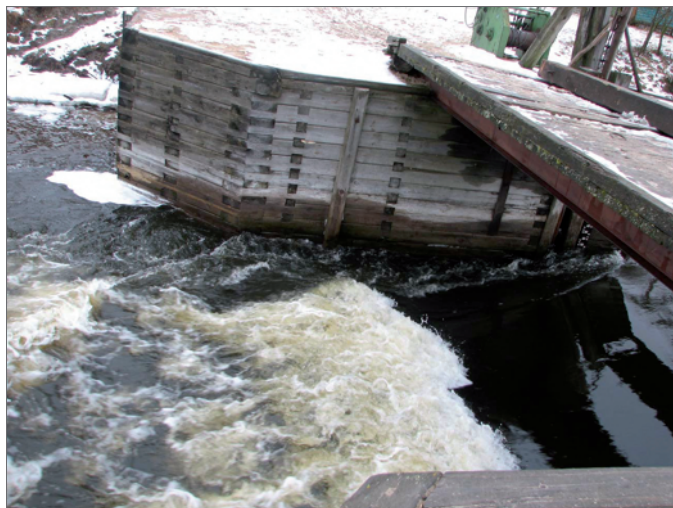
Рисунок 2.14 — Течение через Выжевский водоспуск в период весеннего половодья
