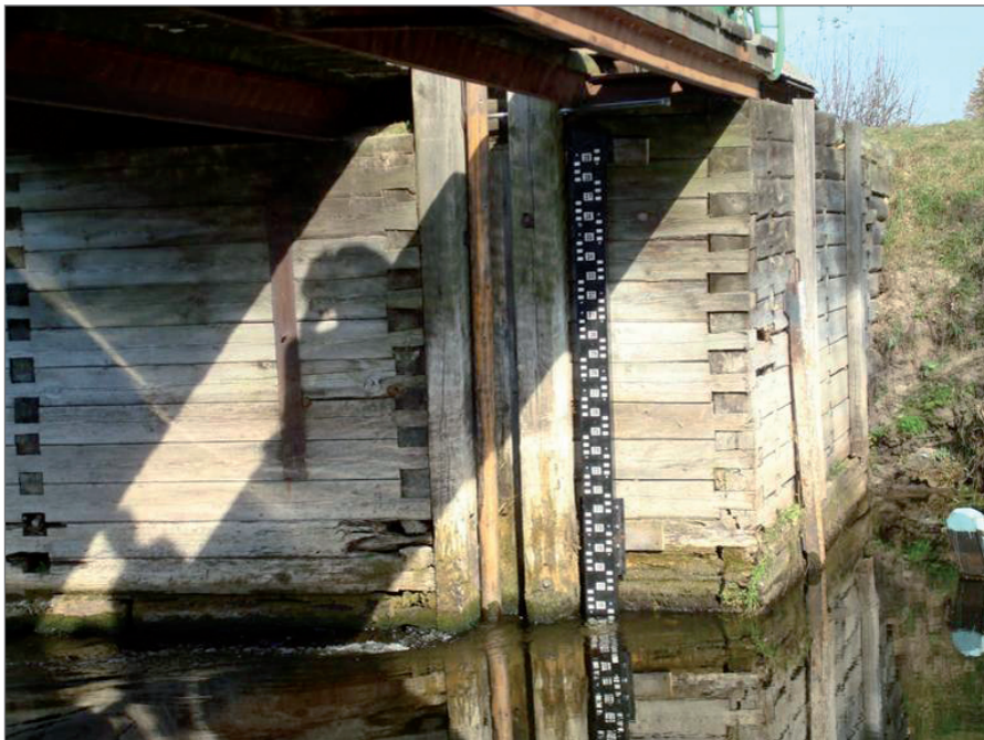
Рисунок 4.4 — Уровнемерная рейка, установленная на Выжевском водоспуске
