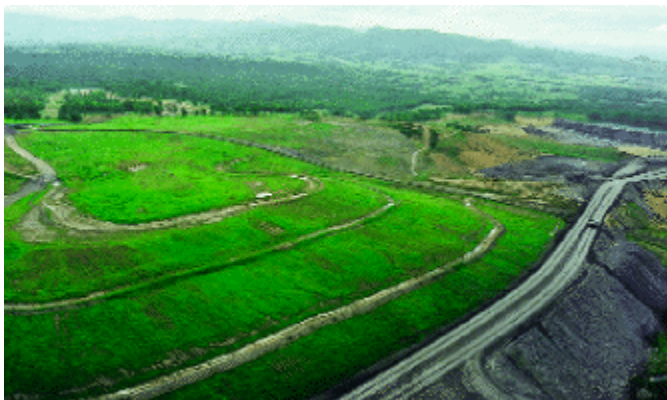
Рисунок 0-1 Окончательное восстановительное покрытие (слой) угольного породного отвала
